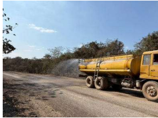
รูปที่ 2.2-6 การฉีดพรมน้ำบนเส้นทางถนนลูกรัง
