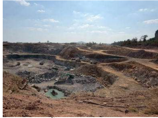
รูปที่ 2.2-1 การเปิดหน้าเหมืองในลักษณะขั้นบันได
